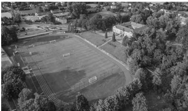
Kompleks lekkoatletyczny z lotu ptaka
